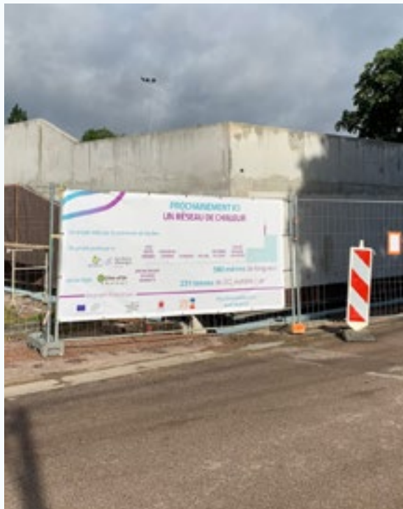
Bâche de chantier à Saulieu
