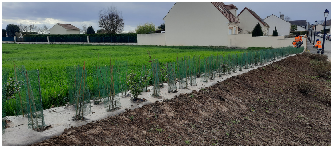
Crédit photo : SIAH Croult et Petit Rosne - Talus fossé conçu pour prévenir les coulées de boue provenant d'un champ agricole
