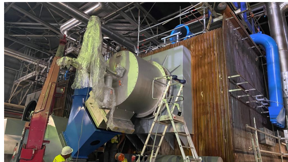
Modification du brûleur de la chaudière GES3
