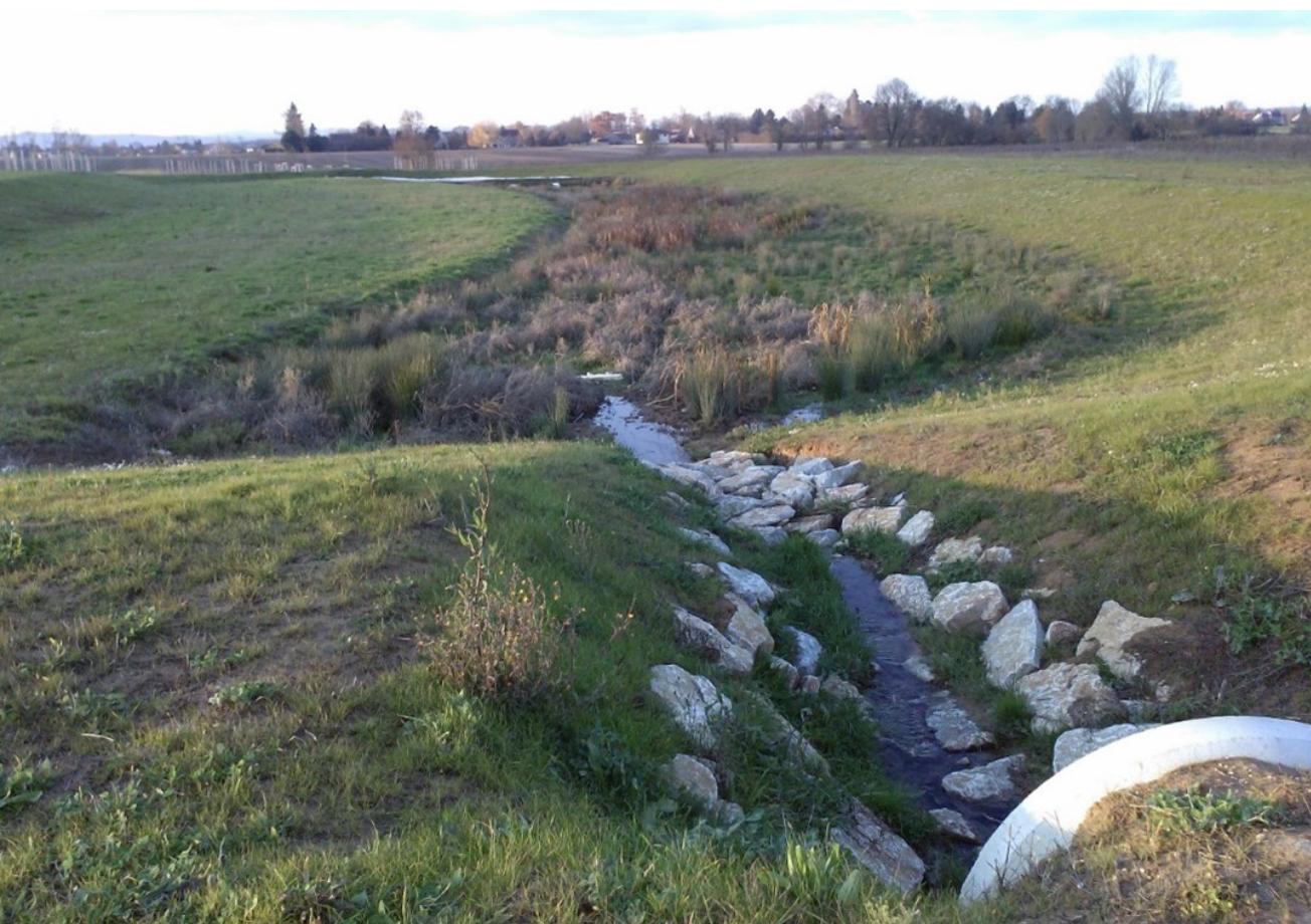
Crédit photo : Le Grand Chalon Agglomération - Bassin de rétention sur la ZAE Saône-Or (21)
